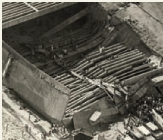
Os bombeiros de Minas Gerais trabalharam arduamente na maior tragédia da construção civil brasileira. Em 1971, o prédio, em fase final de construção, do Parque de Exposição da Gameleira, desabou, deixando 69 vítimas fatais e muitos mutilados.
