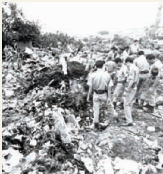
A Vila Barraginha, em Contagem, desabou em 18 de março de 1992. As causas prováveis da tragédia relacionam-se à presença de argila de baixa resistência na composição do solo. Os trabalhos de busca, encabeçados pelo Corpo de Bombeiros, duraram mais de um dia.
