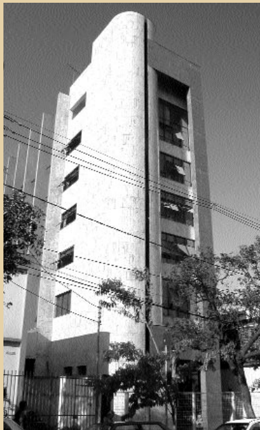
Novo prédio da Justiça Militar, no Barro Preto, onde funcionam as auditorias, será oficialmente inaugurado dia 08 de novembro
