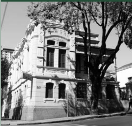
Casarão na rua Santa Rita Durão, 1.263, primeira sede da Justiça Militar em Minas
