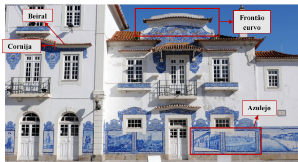
Figura 16 – Edifício da Estação Ferroviária. Aveiro - Portugal. Fonte: Imagem cedidas pelo TCP/ARPT Centro de Portugal
